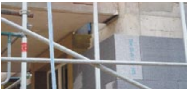
Attēls 4.2. Starp balkonu un ēkas sienu neveidosies aukstuma tilts. Starp sienu un balkonu ir sprauga, kur ievietot siltumizolācijas materiālu. Nelielais savienojuma punkts starp sienu un balkona plāksni ir noklāts ar materiālu, kam ir zema siltumvadītspēja (avots: Auraplan)
