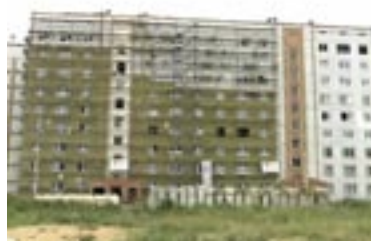
Attēls 5.4. Ēkas siltināšanas process
