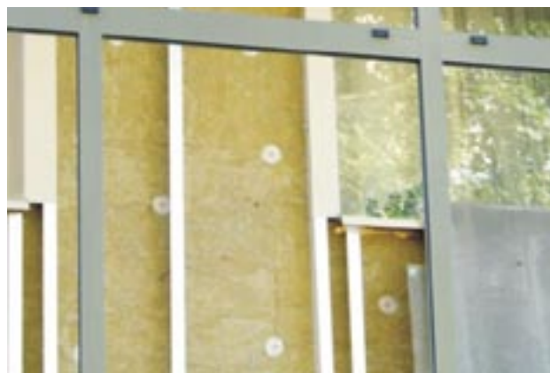
Attēls 4.5. Fiksējošo elementu izmantošana siltumizolācijas materiālu piestiprināšanā (avots: Auraplan)
