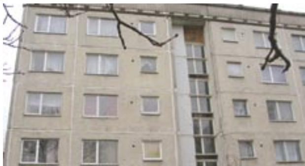
Attēls 5.9. Ēkas izskats pirms siltināšanas
