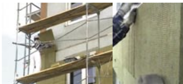
Attēls 5.5. un 5.6. Siltumizolācijas slāņa uzklāšana
