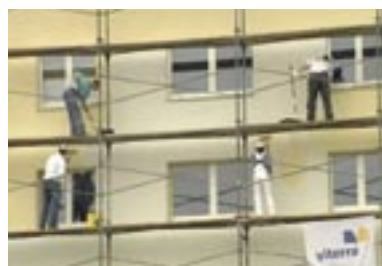
Attēls 5.7. Fasādes apdares beigu posms – krāsošana
