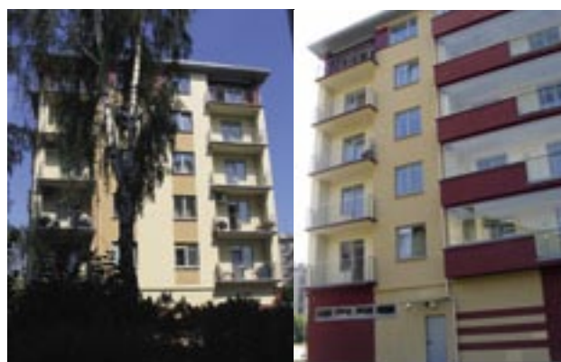
Attēls 5.17. Ēkas galu fasādes
