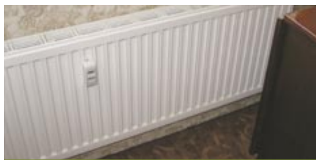
Attēls 5.3. Alokatora izvietojums pie radiatora
