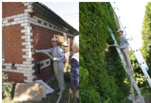
Attēls 5.22. Ēkas fasāžu siltināšanas process
